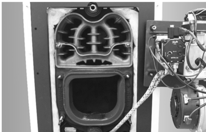
Abb. 66: Geöffneter Kessel (Der abgebildete Brenner entspricht evtl. nicht dem gelieferten.)
