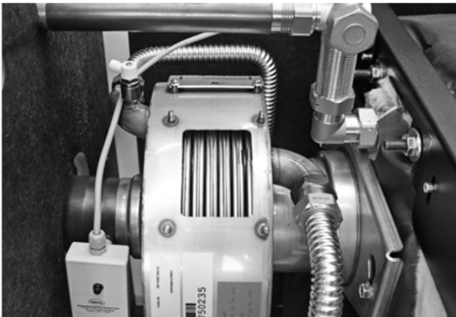
Abb. 69: Reinigungsöffnung des RWT
