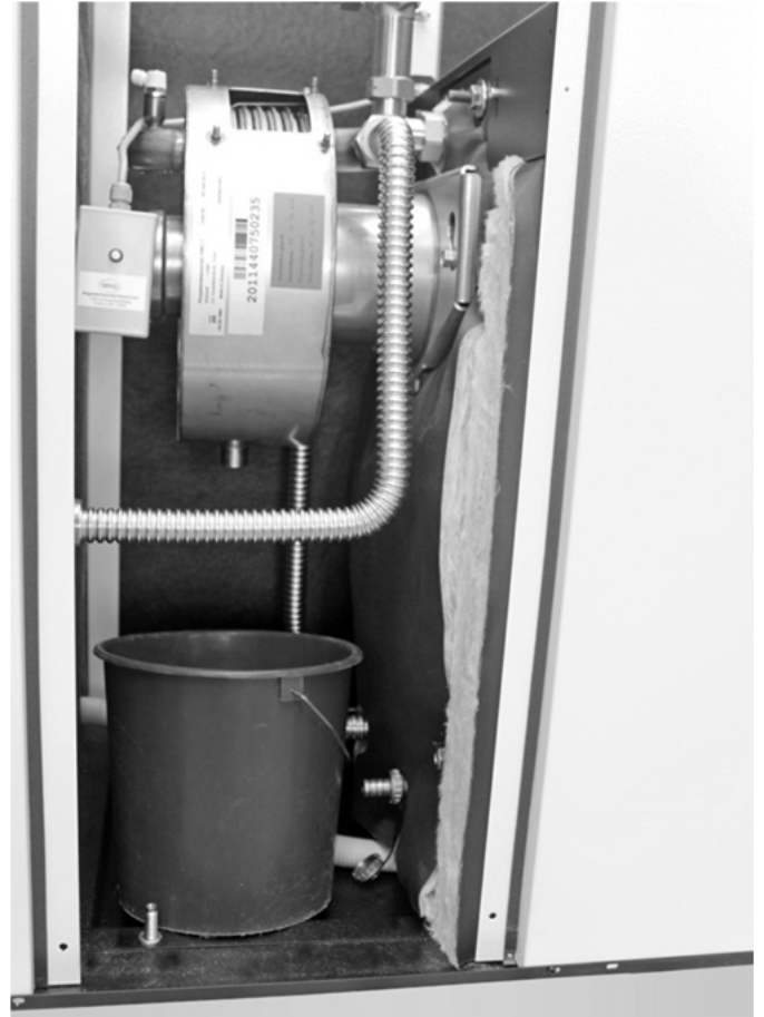
Abb. 70: Zur Reinigung vorbereiteter RWT
