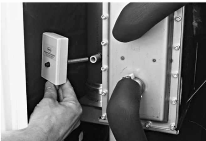
Abb. 8: Abgastemperaturbegrenzer mit ATB-Hülse am Abgasrohr
