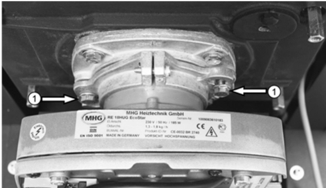
Abb. 34: Brennerbefestigungsschrauben
