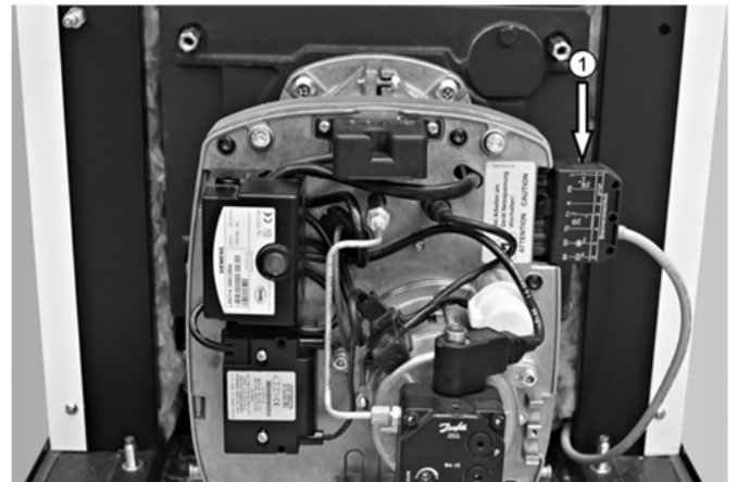
Abb. 12: Montage des Euro-Anschluss-Steckers ①
