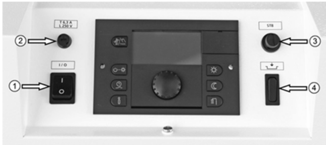
Abb. 1: Unit-Schaltfeld mit Sicherheits- und Funktionselementen
