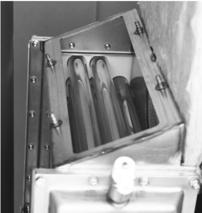
Abb. 52: Reinigungsöffnung des GWT
