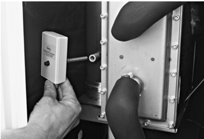
Abb. 53: Abgastemperaturbegrenzer mit ATB-Hülse am Abgasrohr
