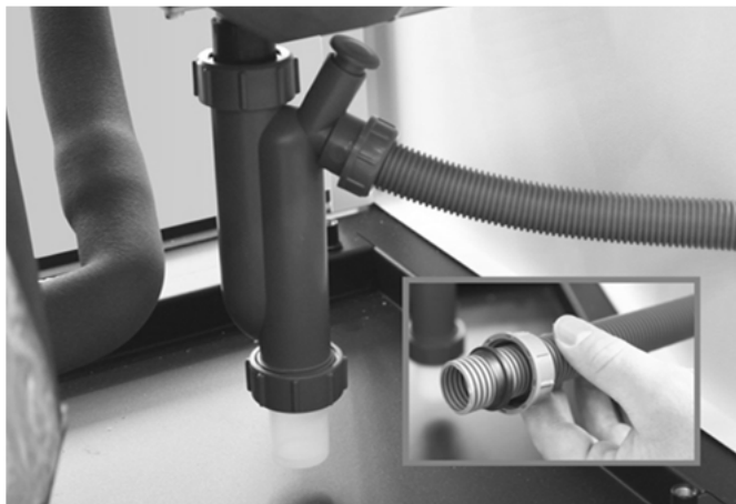
Abb. 10: Montage des Kondensatschlauchs
