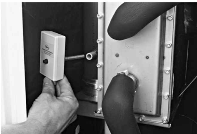
Abb. 8: Abgastemperaturbegrenzer mit ATB-Hülse am Abgasrohr
