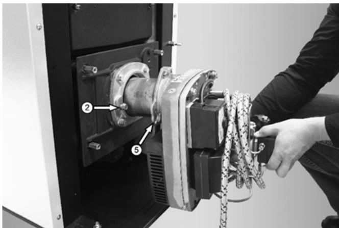
Abb. 4: Brennerbefestigung
