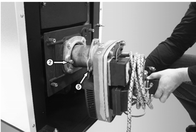
Abb. 4: Brennerbefestigung
