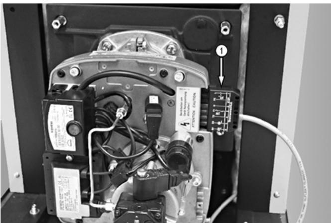
Abb. 11: Montage des Euro-Anschluss-Steckers ①
