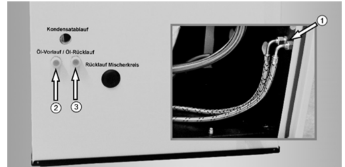
Abb. 10: Montage der Ölschläuche
