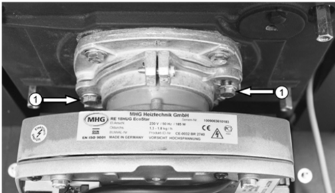
Abb. 20: Brennerbefestigungsschrauben ①
