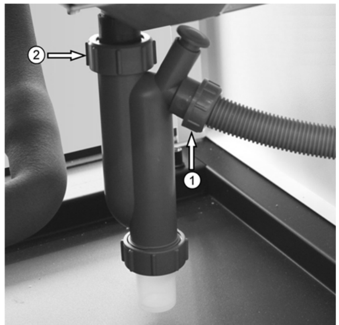
Abb. 50: Demontage des Kondensat-Siphons
