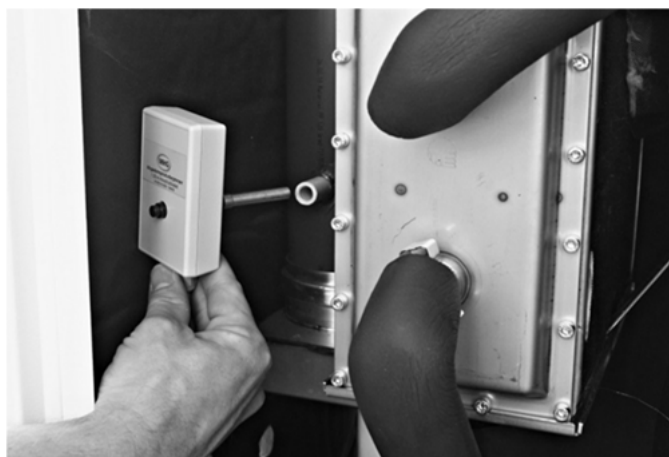
Abb. 8: Abgastemperaturbegrenzer mit ATB-Hülse am Abgasrohr
