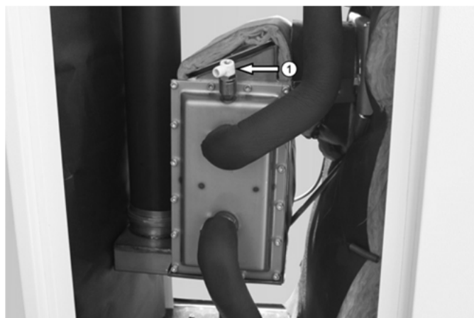
Abb. 21: Entlüfter ① des Abgaswärmetauschers
