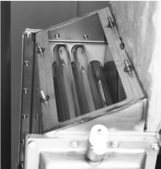
Abb. 52: Reinigungsöffnung des GWT
