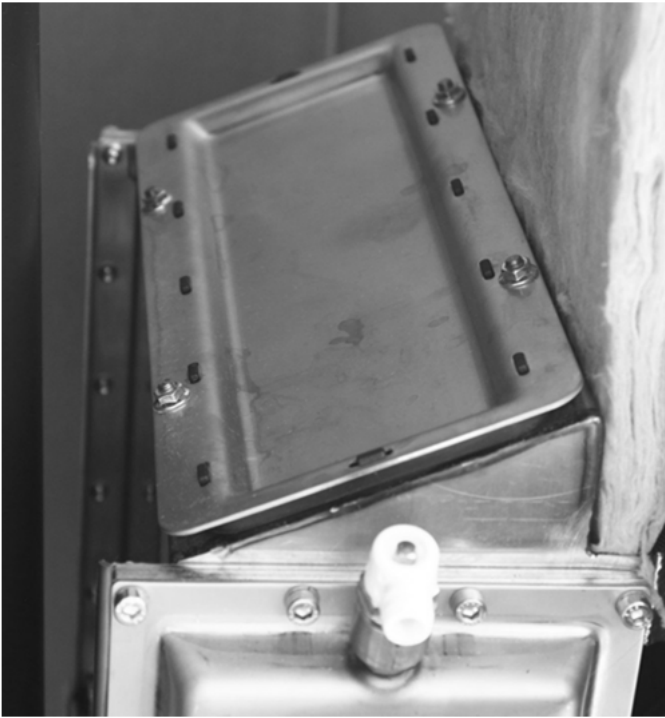
Abb. 51: Reinigungsklappe des GWT
