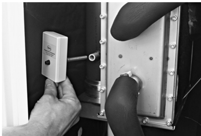
Abb. 53: Abgastemperaturbegrenzer mit ATB-Hülse am Abgasrohr
