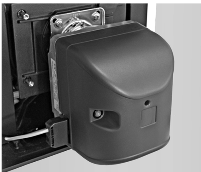
Abb. 4: Montierter Brenner
