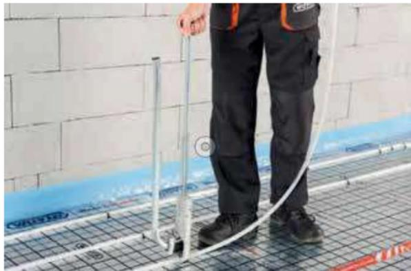
Abb.: Rohrverlegung mit Tackernadeln/Tackerwerkzeug
