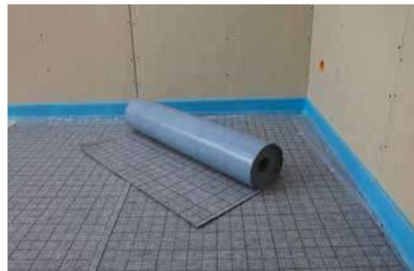
Abb.: Klettrolle und Randdämmstreifen
