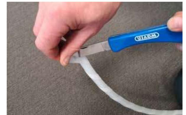
Abb.: Klettband muß vor Aufschieben der Überwurfmutter vom Rohr entfernt werden !
