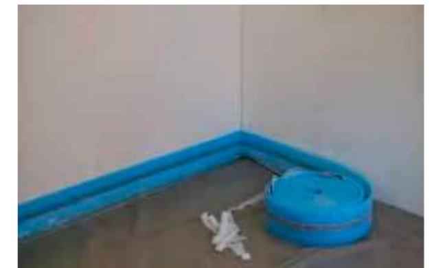
Abb.: Verlegung Randdämmstreifen
