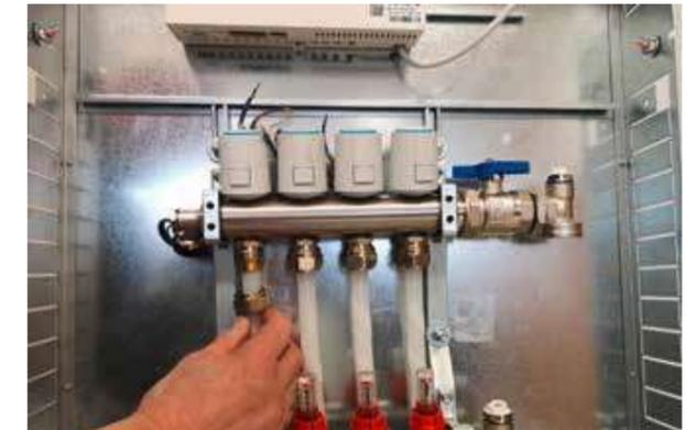
Achtung: Der Übergang auf Eurokonus muss bis zum Anschlag in das Heizrohr eingeführt werden. Je nach Heizrohr kann hierfür eine erhöhte Kraftanstrengung benötigt werden. Ein Einschlagen des Übergangs beschädigt die Abdichtfläche und hat zu unterbleiben.
