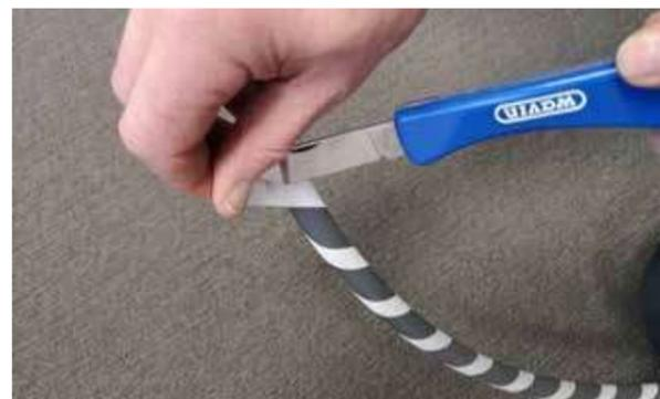
Das Rohr für den Anschluss am Verteiler in der Länge grob abschneiden, an den Verteilerbalken anhalten und das Maß Unterkante Anschluss Eurokonus markieren.
