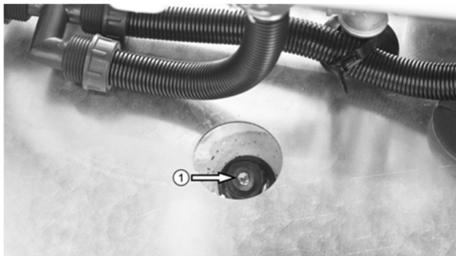
Abb. 88: Position der Magnesium-Schutzanode ①
