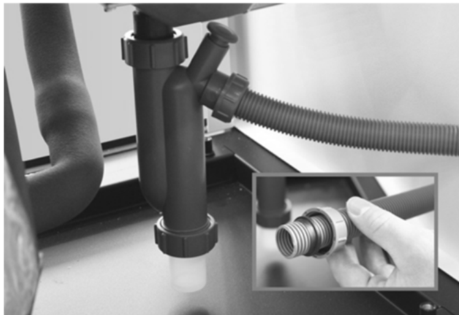
Abb. 10: Montage des Kondensatschlauchs
