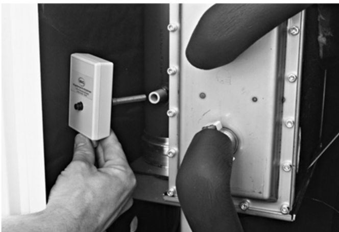
Abb. 8: Abgastemperaturbegrenzer mit ATB-Hülse am Abgasrohr
