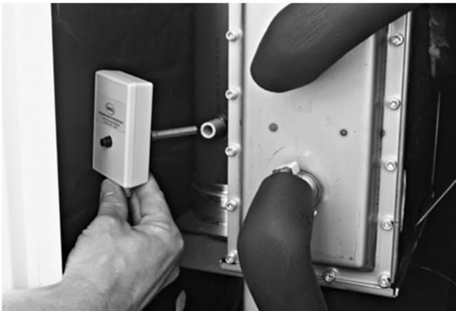
Abb. 53: Abgastemperaturbegrenzer mit ATB-Hülse am Abgasrohr
