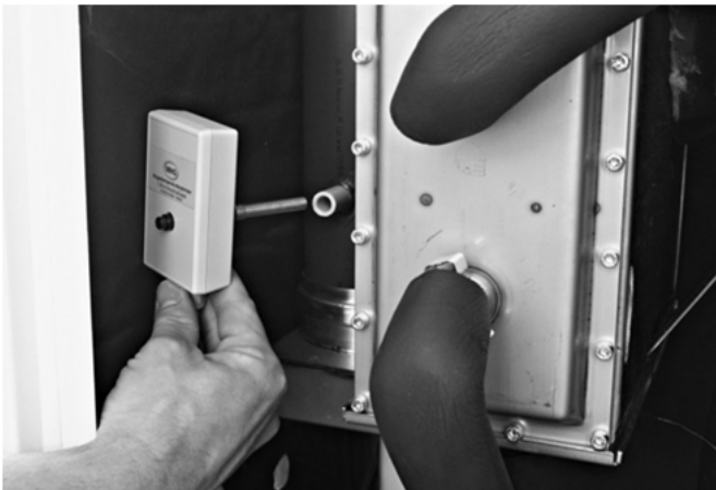
Abb. 53: Abgastemperaturbegrenzer mit ATB-Hülse am Abgasrohr
