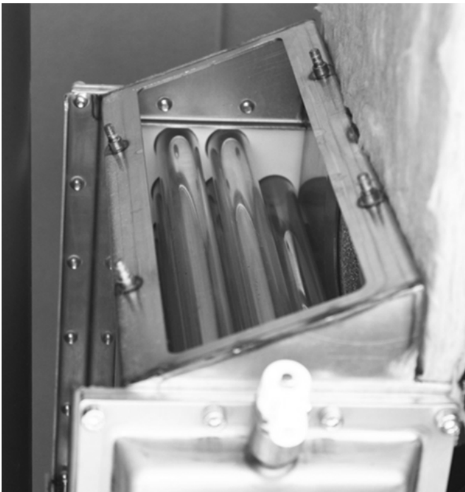
Abb. 52: Reinigungsöffnung des GWT
