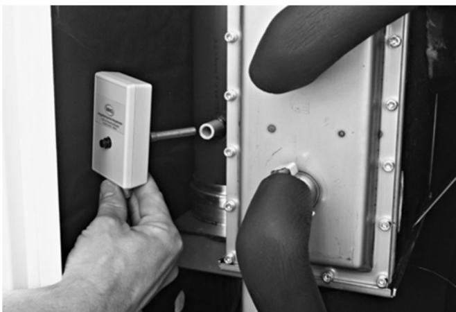
Abb. 8: Abgastemperaturbegrenzer mit ATB-Hülse am Abgasrohr
