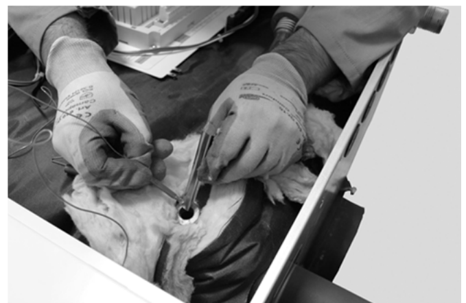
Abb. 46: Einführung des Kesseltemperaturfühlers und des Fühlers des Sicherheitstempurbegrenzers
