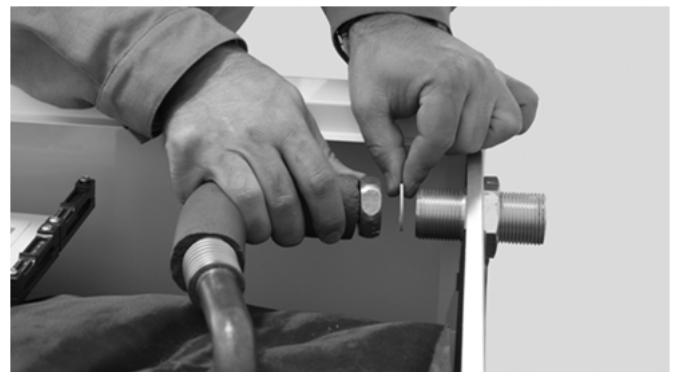
Abb. 23: Montage der verbliebenen Seite vom Rohr Kessel/ Kesselsicherheitsgruppe
