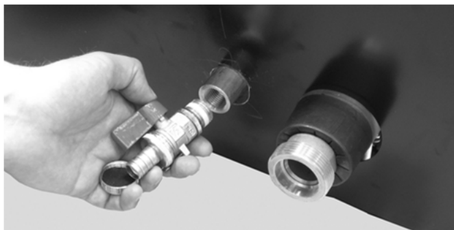
Abb. 25: Montage KFE-Kugelhahn
