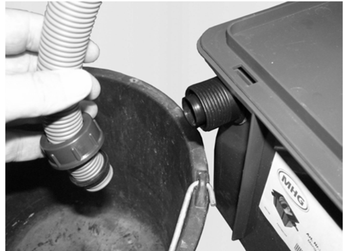
Abb. 71: Demontage des Kondensatschlauchs
