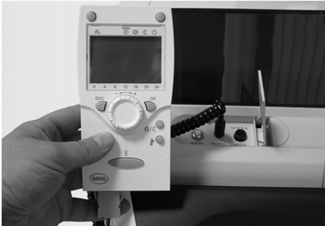
Abb. 57: Mit dem Kesselschaltfeld verbundene Bedieneinheit
