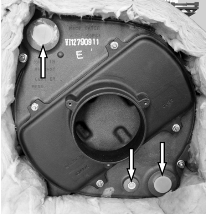
Abb. 11: Verschlusskappen der Rohranschlüsse
