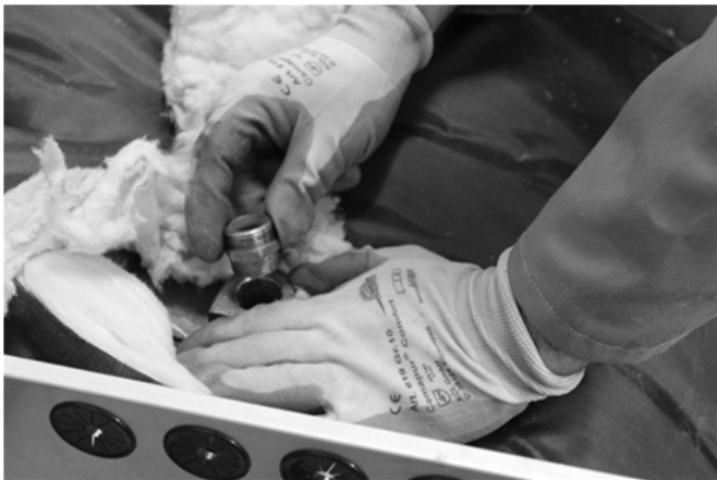
Abb. 20: Montage Doppelnippel
