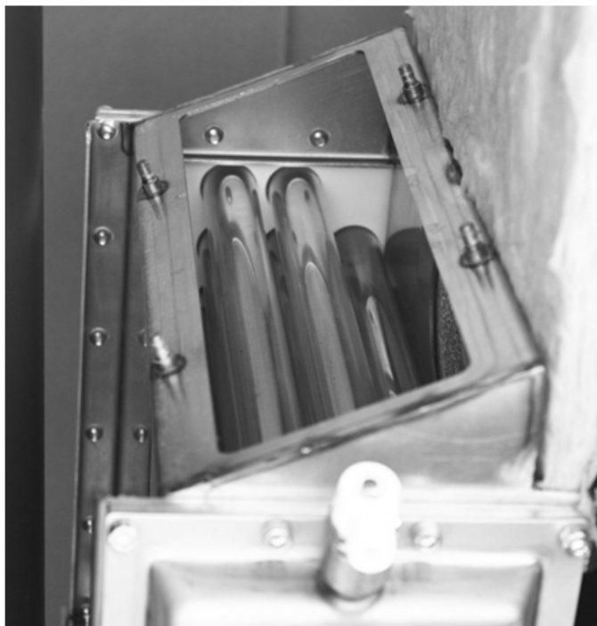
Abb. 52: Reinigungsöffnung des GWT
