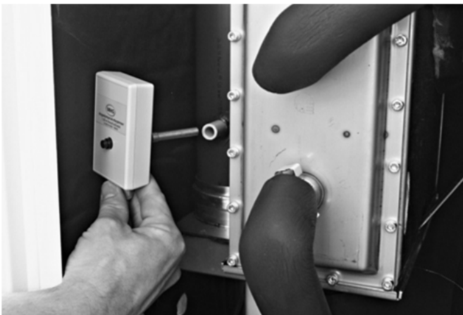
Abb. 8: Abgastemperaturbegrenzer mit ATB-Hülse am Abgasrohr
