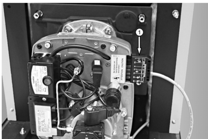
Abb. 11: Montage des Euro-Anschluss-Steckers ①
