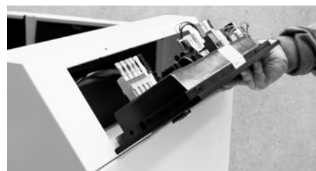
Abb./Fig. 11: Ausgeklapptes Unit- Schaltfeld Ouverture du tableau de commande de l'unité
