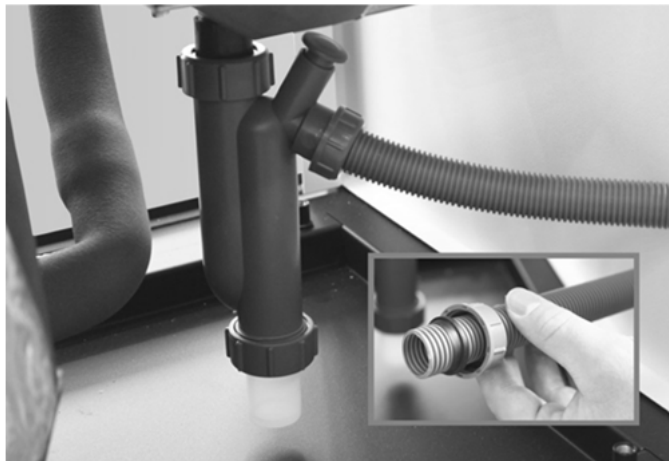
Abb. 10: Montage des Kondensatschlauchs
