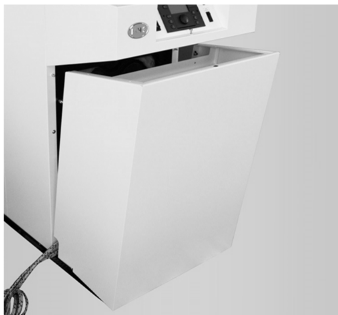
Abb. 44: Demontage der Kesselhaube
