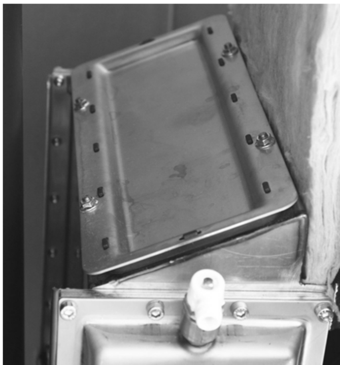
Abb. 51: Reinigungsklappe des GWT
