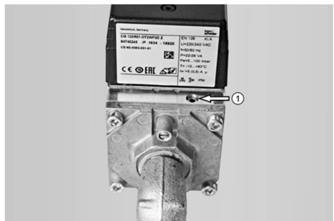
Abb. 12: Drosselschraube zur Feineinstellung der Gasmenge
