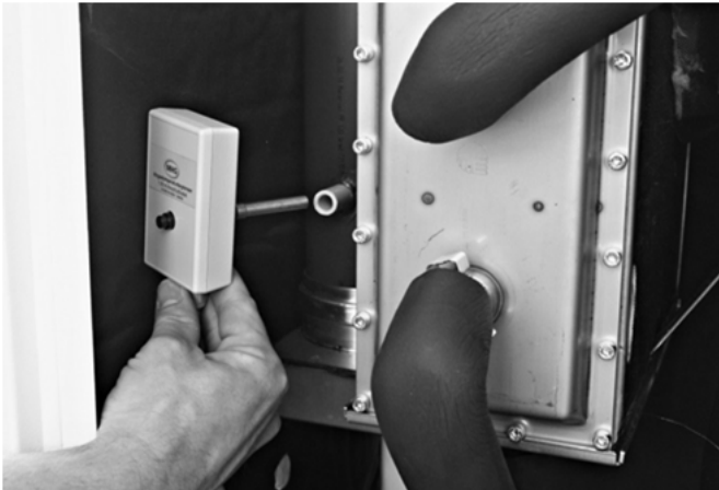
Abb. 53: Abgastemperaturbegrenzer mit ATB-Hülse am Abgasrohr
