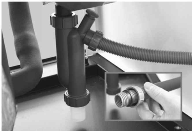
Abb. 10: Montage des Kondensatschlauchs
