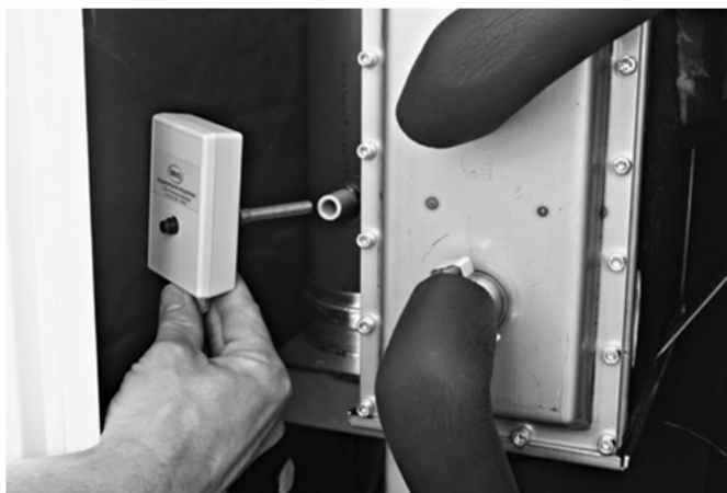
Abb. 8: Abgastemperaturbegrenzer mit ATB-Hülse am Abgasrohr
